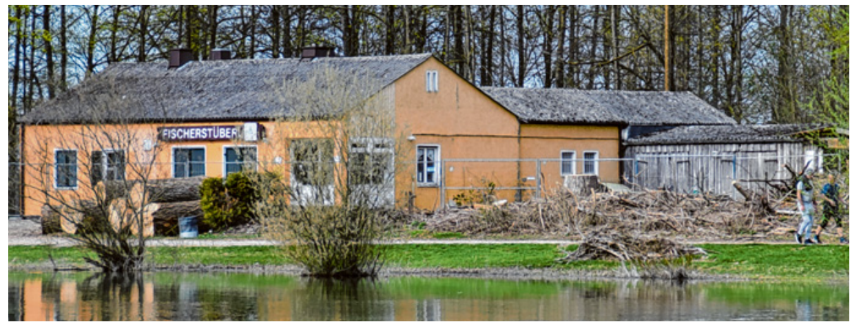
Die Ausflügler am Augsburger Autobahnsee müssen in diesem Jahr auf die Bewirtung durch das Fischerstüberl verzichten. Das Gebäude wird abgerissen. Foto: Stephanie Lorenz
